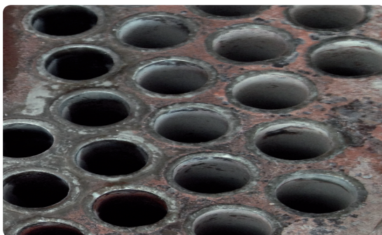
Herkömmliche Wärmetauscher verdrecken schnell. Die Folgen: weniger Leistung, hoher Energieverbrauch.
